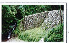
アカタン砂防堰堤群(奥の東石)
