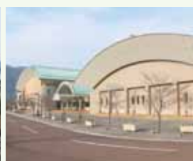
体育館・格技場
