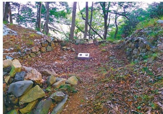
本丸跡と北西に延びる連郭曲輪群の尾根を断ち切る堀切の石垣
