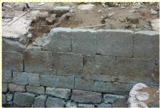
切込ハギが確認されます。打ち込みハギの部分は堀の水面下のようです。
